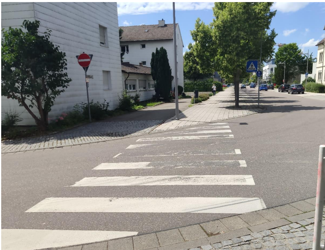
Abbildung 46: FGÜ an der abknickenden Vorfahrtsstraße
