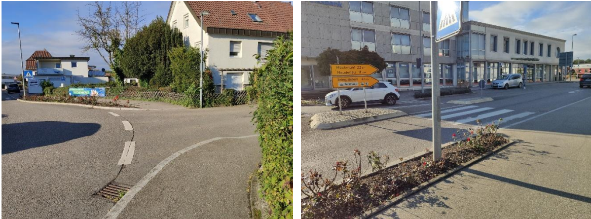
Abbildung 34: KVA Kocherwaldstraße – Kreisverkehrsarm Tulpenweg (l.) und Kocherwaldstraße Nord (r.)
