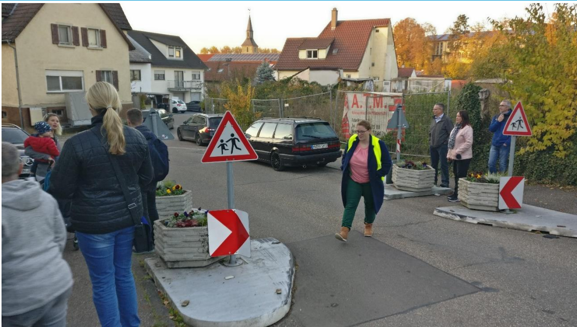
Abbildung 55: Vorgezogene Seitenräume in der Neckarsulmer Straße
