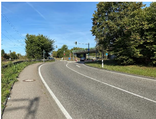
Unterführung K 2117 / Brücke B 27
