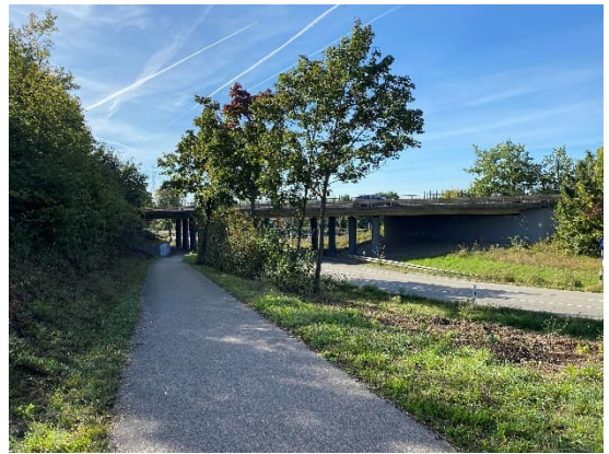
Unterführung K 2117 / Brücke B 27
