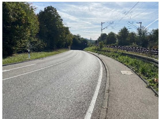
K 2117 zur Unterführung der Bahnstrecke
