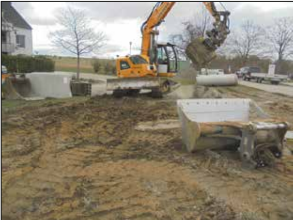
Verlegen Regenwasserkanal „Tübinger Straße“
