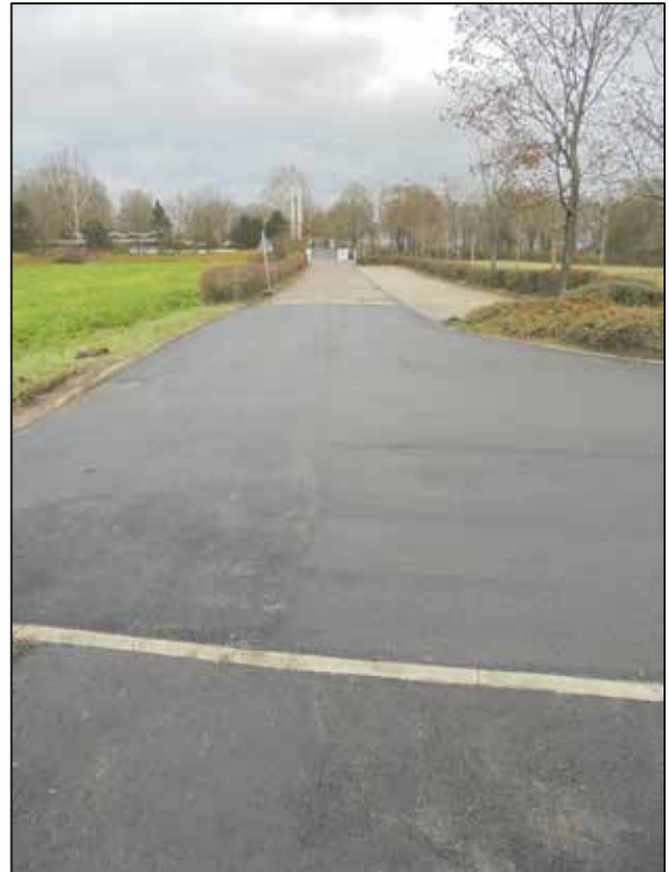
Asphaltbelag beim „Bergfriedhof“ in Kochendorf
