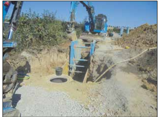
Verlegen der Regenwasserleitung
