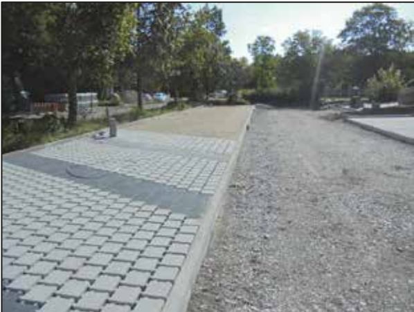
Pflasterarbeiten während der Baumaßnahme
