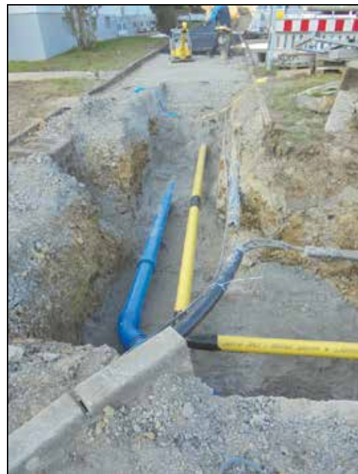
Gas- und Wasserleitung in der „Ohrnberger Straße“
