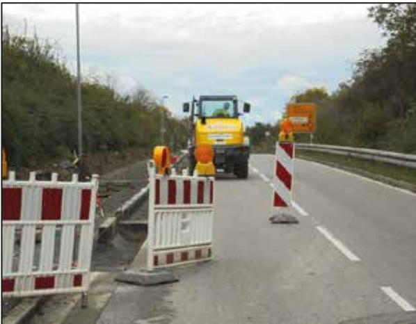
Setzen der Randsteine
