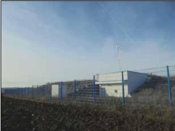
Neue Zaunanlage und neu gestaltete Außenansicht Betriebsgebäude am Hochbehälter Heuchlingen
