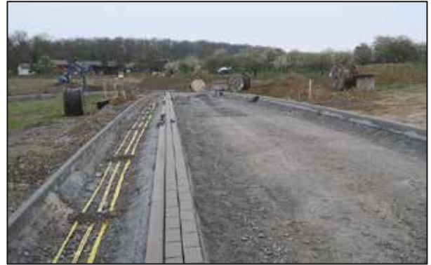
Straßenbauarbeiten im Zuge der Erschließung
