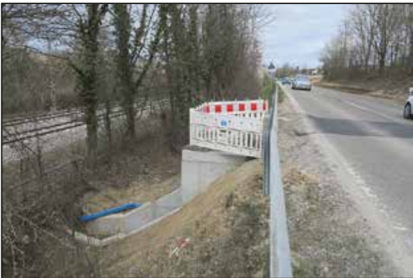
Einlaufbauwerk oberhalb des Baugebietes
