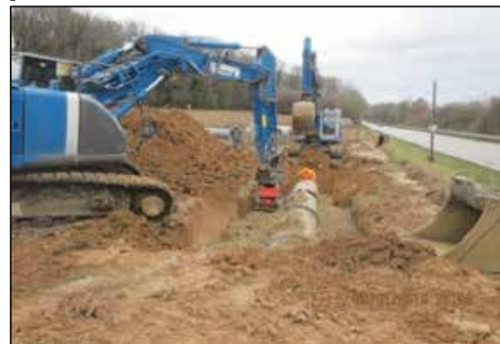
Bau der Rohrleitung entlang der L1096
