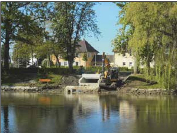
Drosselbauwerk zur Steuerung des Wasserspiegels
