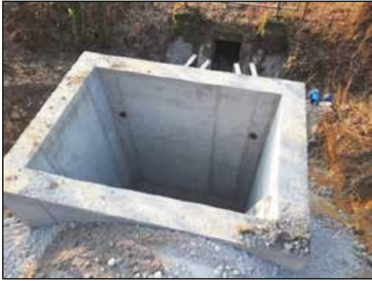
Absturzbauwerk zwischen L1096 und Bahnlinie
