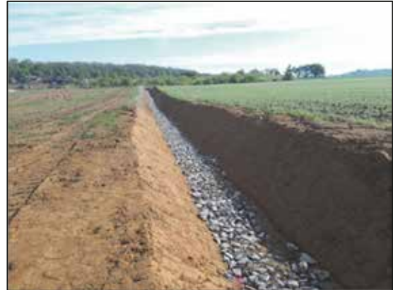
Abfanggraben oberhalb vom Baugebiet
