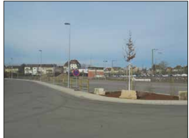
Neue Gewerbestraße „Am Stellwerk“ mit Parkplatz
