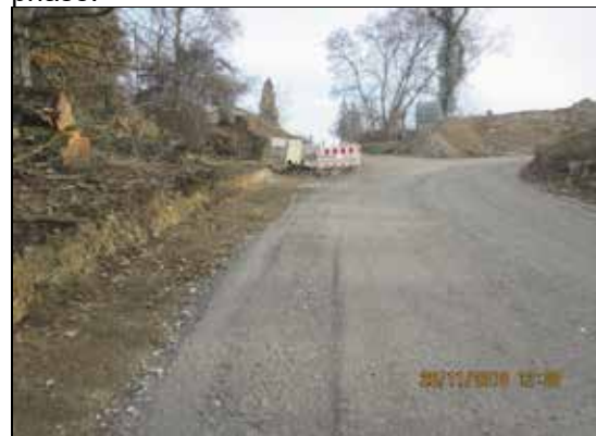
Straßenbauarbeiten in der Kressbacherstraße
