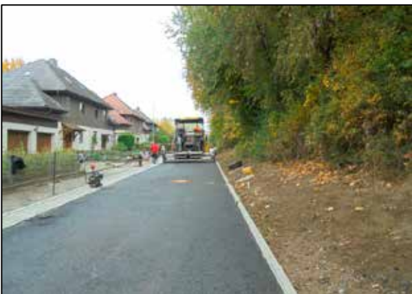
Straßenbau „Beim Alten Schacht“
