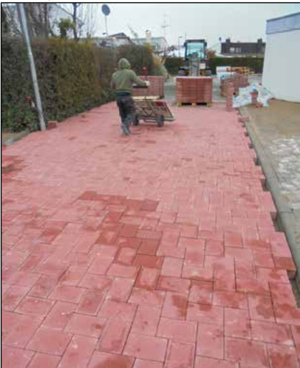
Einbau Betonpflasterbelag, Fahrbahn Kilianstraße
