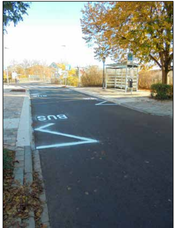
Bushaltestelle mit neuer Buswarte Halle
