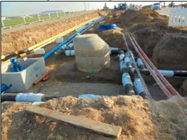
Leitungsbau Erschließung 1. BA „Obere Fundel“
