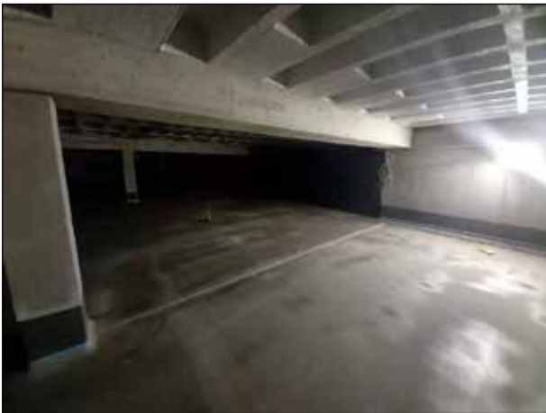
Sanierung der Tiefgarage Rathaus Dezember 2020
