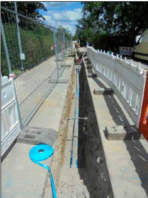
Wasserleitungsgraben während der Baumaßnahme (Hofgartenstraße)
