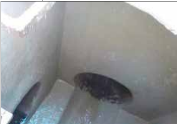
Sanierter Kanalschacht
