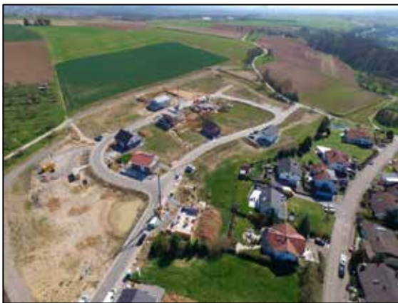
Anfang 2020 die ersten Häuser stehen schon
