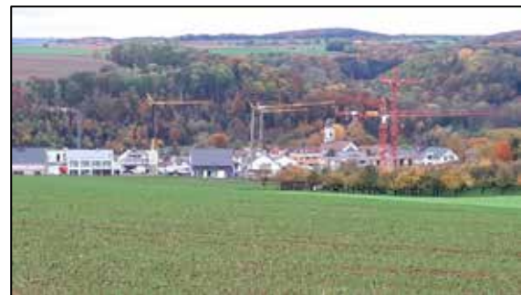
Blick von Osten auf das Baugebiet.
