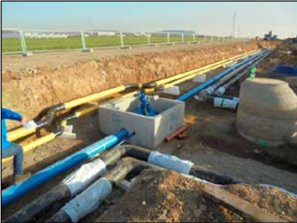
Leitungsbau Erschließung 1. BA „Obere Fundel“
