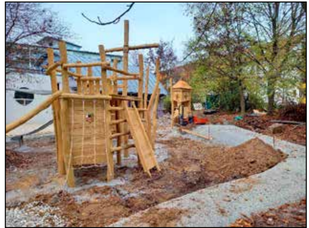
Erneuerung der Außenanlagen KiTa Plattenwald November 2022
