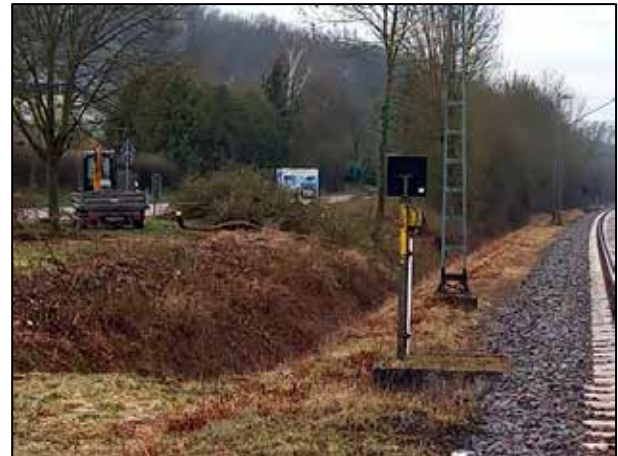
Vorbereitung der Baustelle.
