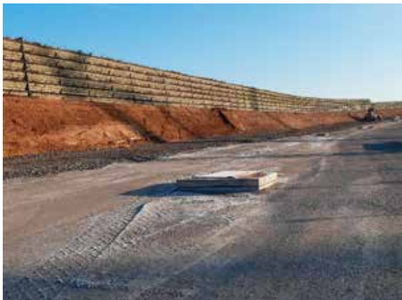
Neue K2117, Gehweg und Lärmschutzwand
