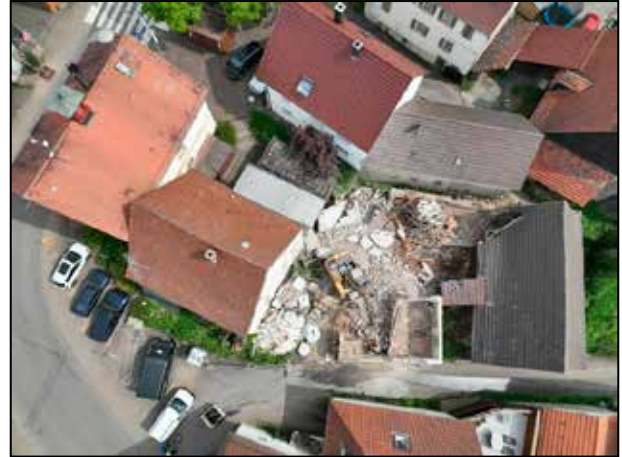
Abbrucharbeiten Torstraße 20 Mai 2022
