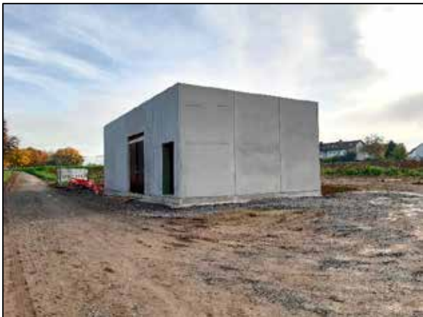
BHKW-Gebäude Neuenstädter Straße Abschluss Rohbauarbeiten November 2022
