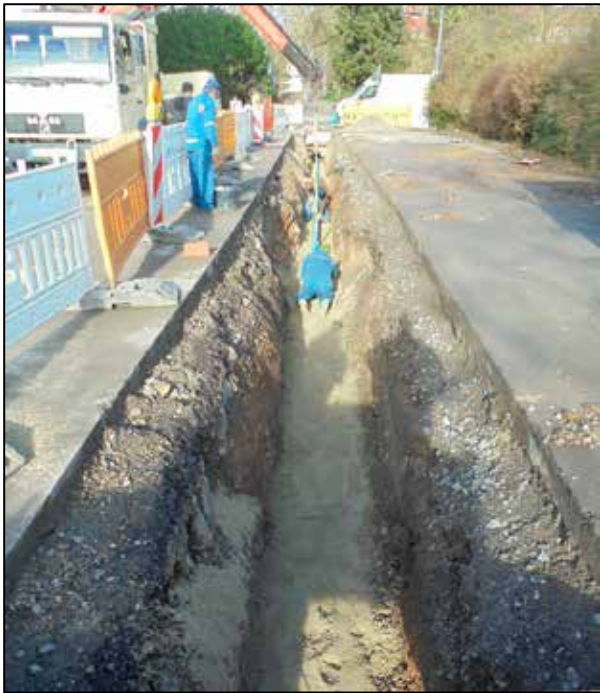
Neuverlegen Wasserleitung DN 100 (GGG)
