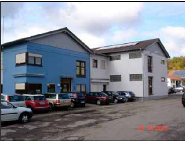
Baubetriebshof - Stadtarchiv im Obergeschoss
