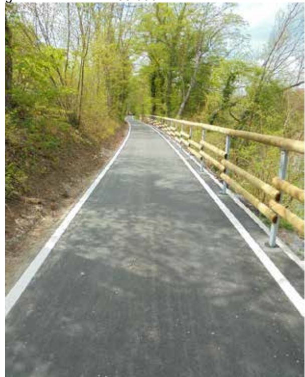
Abschnitt Vollausbau mit neuem Holzgeländer
