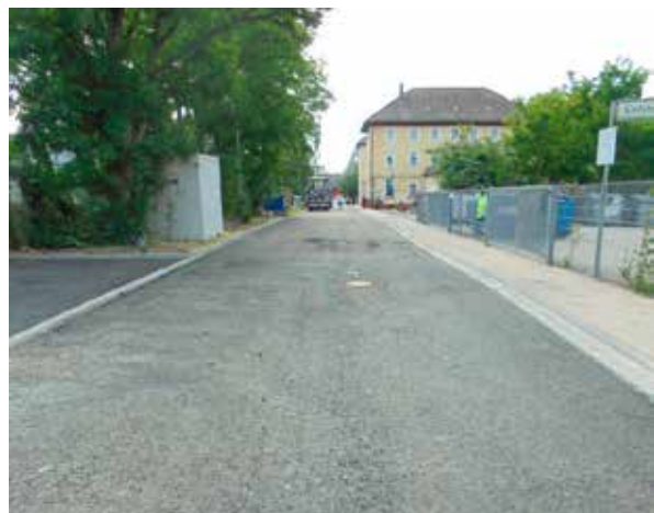
„Saline“, vor Einbau der Asphaltdeckschicht
