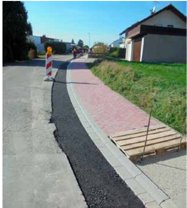
Neuer Gehweg in der Martinusstraße
