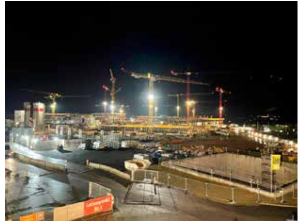
Bild Bauarbeiten Obere Fundel bei Nacht
