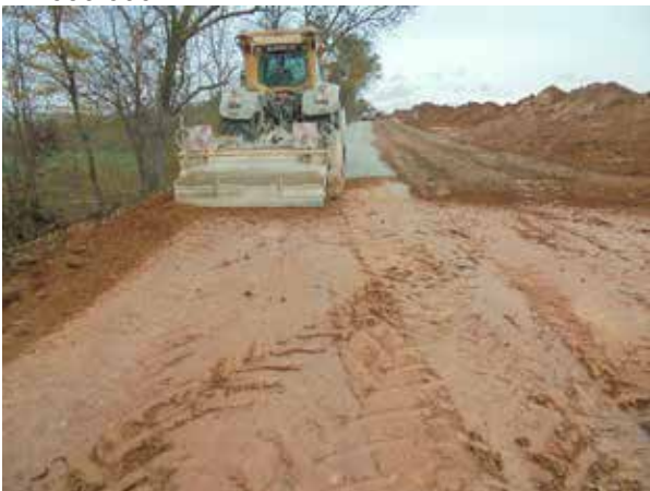
Verfestigen des anstehenden Bodens mit Kalk
