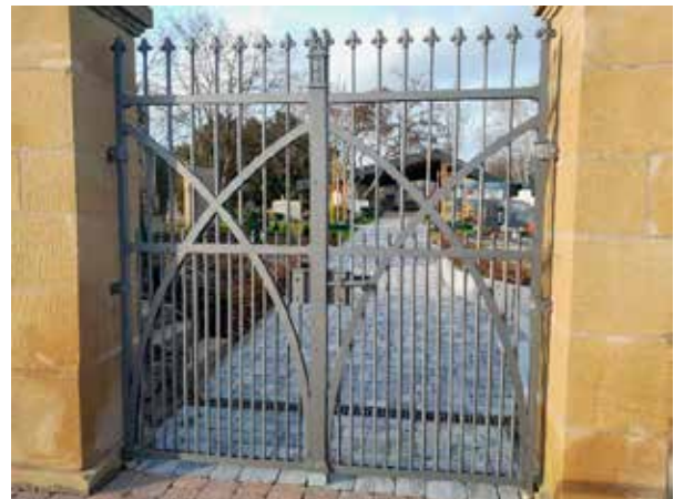
Historisches Eisentor nach Sanierung
