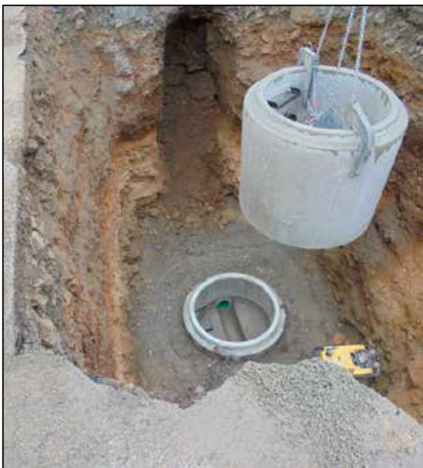
Versetzen eines Fertigteil-Kanalschachts DN 1000
