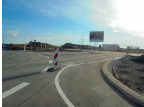
Neue K2117, Anschluss an Kreisverkehr
