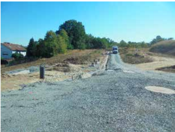
Leitungsbau/Kabelbau Erweiterung Brauerei-Elsässer-Straße
