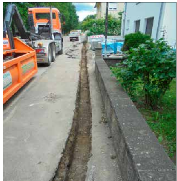
Kabelgraben Oedheimer Straße
