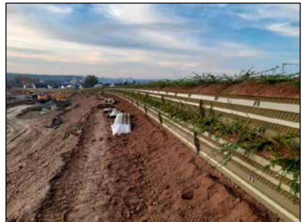
Lärmschutzwall im Bau
