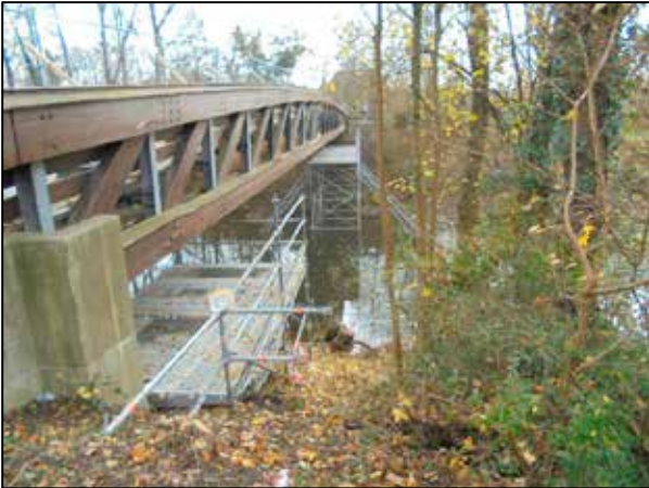
Gerüstbauarbeiten am Kochersteg
