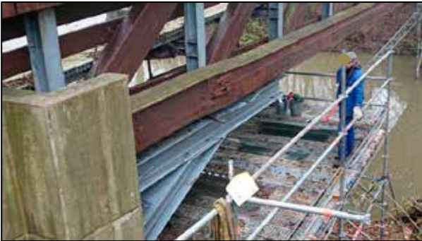
Unterstützende Stahlkonstruktion
