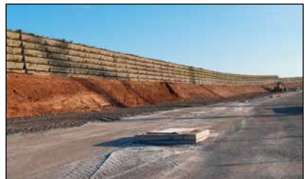
Lärmschutzwall entlang neuer K 2117
