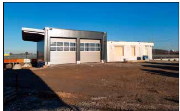
Ausrückwache mit BHKW während der Bauphase Dezember 2021
