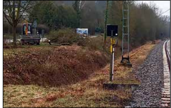
Vorbereitung der Baustelle.
