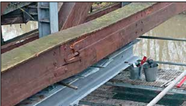
Unterstützende Stahlkonstruktion
