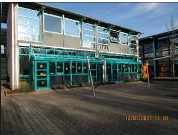
Grundschule Plattenwald - Neue Wintergartenelemente Januar 2022
