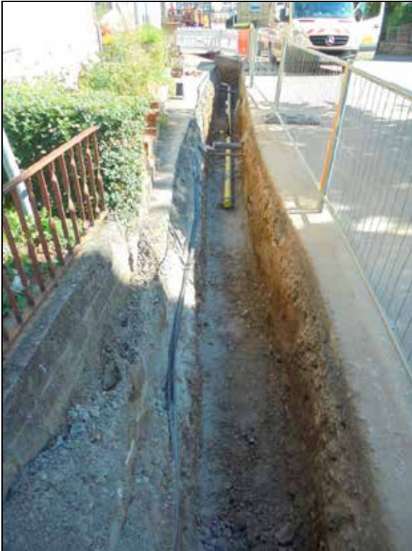
Gasleitungsgraben Hagenbacher Straße
