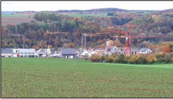
Blick von Osten während der aktivsten Bauphase.
